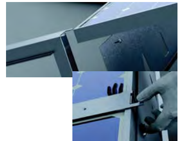
Modul einschieben und mit Biegeglasche sichern.
