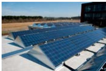
*Das Montagesystem INTERSOL Futura Flat Roof reduziert die statische Belastung auf Flachdächern deutlich gegenüber herkömmlichen Aufständersystemen.
