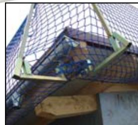
Die „neue“ Blechdach-Ortgang-sicherung für Blechdächer.
