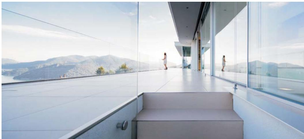
swissFineLine steht für grossflächige, rahmenminimierte Schiebefenster. Transparenz und Filigrantät sind einmalig. Die Bodenführung und die umlaufenden Rahmenprofile sind vollständig in Böden, Decken und seitlich in die Wände eingearbeitet. Vom Rahmen bleibt so praktisch nichts mehr sichtbar und ermöglicht fließende Grenzen zwischen innen und aussen. Lebensraum voller Licht, Luft und Atmosphäre.
